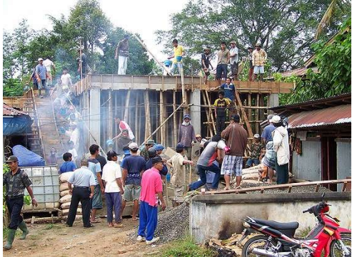
Bau des Bezirksbüros in Tallunglipu
